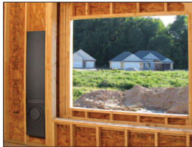
INSERIBILE TRA MONTANTI I CUI ASSI DISTINO FRA DI LORO DI ALMENO 41 CM
